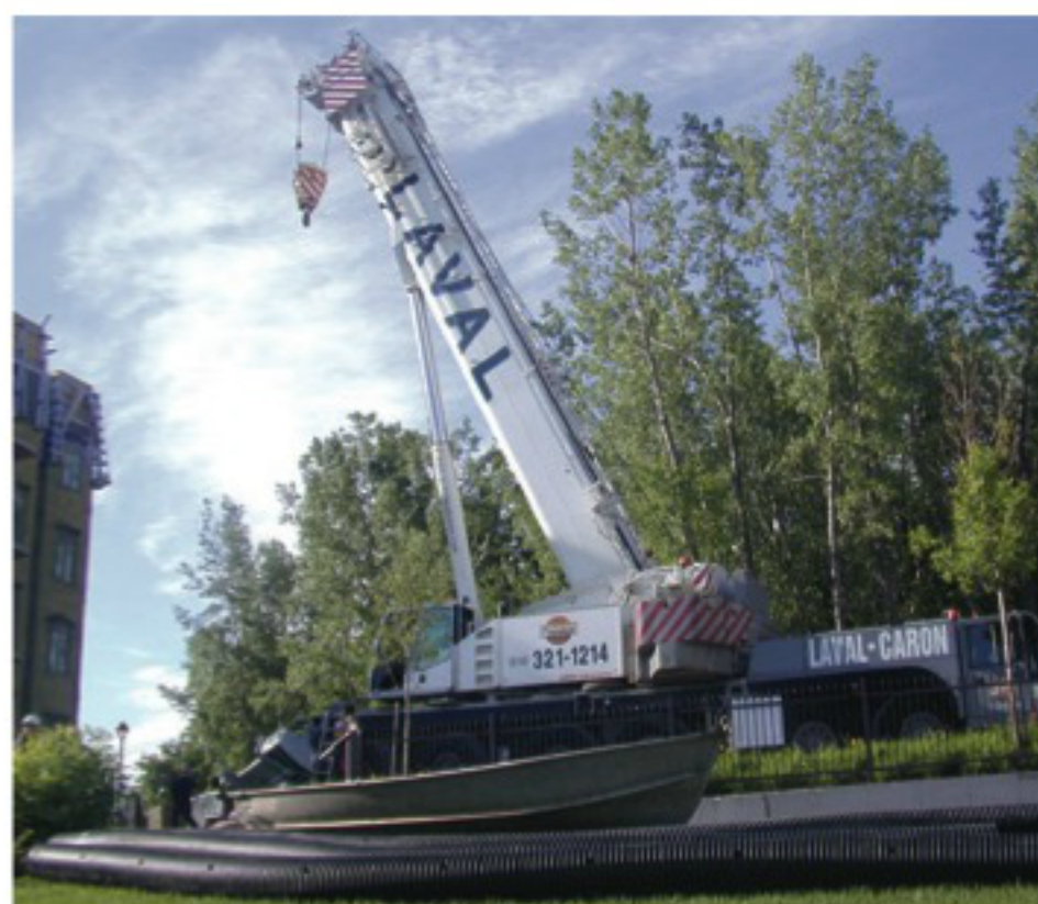
L'assemblage a été exécuté sur terre puis immergé à l'aide d'une grande grue mécanique.
