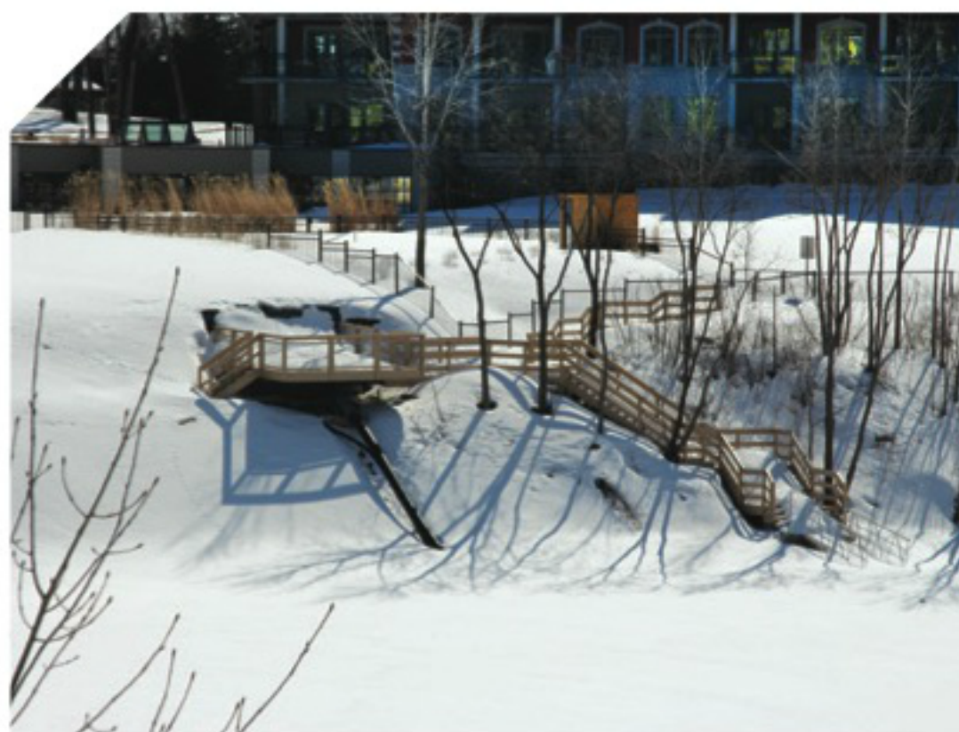
Aménagement de l'installation géothermique en rive.
