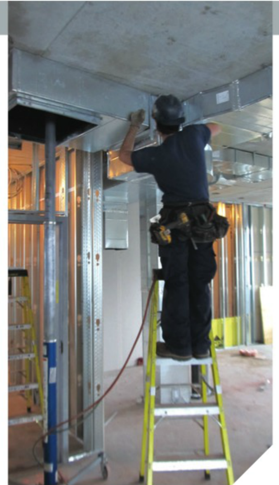
Chaque bâtiment possède sa propre centrale d'air.
